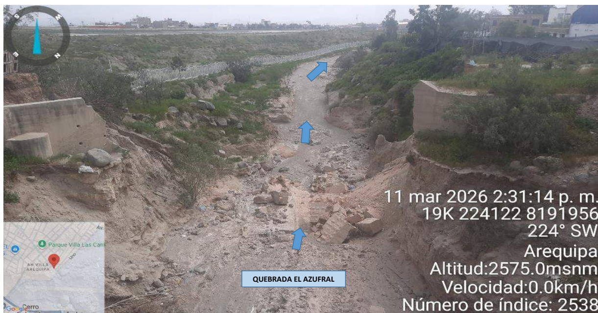
IMAGEN 02: EN ESTE TRAMO SE OBSERVA QUE EN AMBAS MÁRGENES DE LA QUEBRADA EL AZUFRAL, SUS TALUDES SE ENCUENTRAN SOCAVADOS, Y SU CAUCE SE ENCUENTRA COLMATADO.
